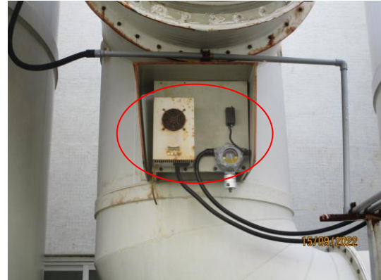
รูปที่ 2 เครื่องตรวจวัดคุณภาพอากาศ (HCL) แบบต่อเนื่อง
